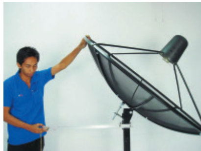
5. ทำการปรับมุมสายหน้าจาน ซ้าย/ขวา
