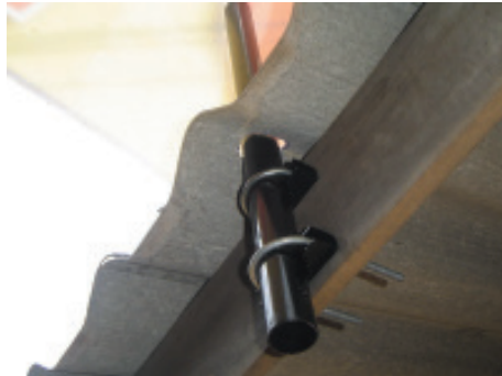
14. ทำการขันน็อตให้แน่น ( ก่อนขันน็อตควรตรวจสอบเรื่องมุมของเสาตั้งงานให้ได้ 90 องศา โดยใช้ตัววัดมุม)
