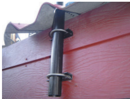
ด้านในการติดตั้งประกับให้เพิ่มแผ่นเหล็กตามรูป
