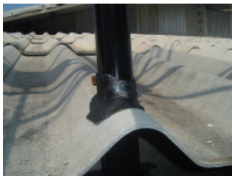
15. ใช้ CORK TAPE ( ก้อนซีทมาที่ใช้ในงานติดตั้งแอร์) มาพันระหว่างเสากับหลังคาที่เจาะไว้ เพื่อป้องกันน้ำรั่ว
