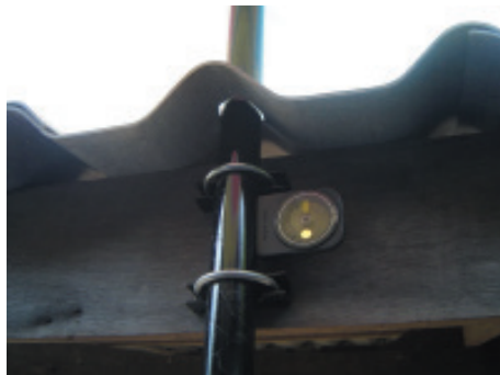
15. ใช้ CORK TAPE ( ก้อนซีทมาที่ใช้ในงานติดตั้งแอร์) มาพันระหว่างเสากับหลังคาที่เจาะไว้ เพื่อป้องกันน้ำรั่ว
