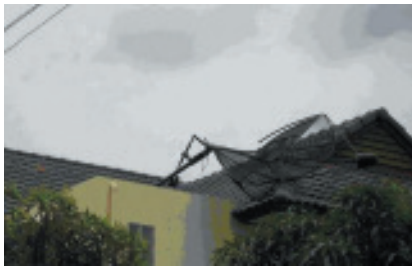
การติดตั้งจานที่ไม่ได้มาตรฐาน หรือไม่เรียบร้อยจะทำให้เกิดปัญหาจานล้มได้ง่าย
