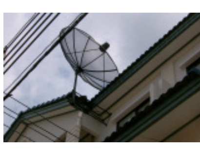
ติดตั้งเสร็จแล้วมีความแข็งแรงแบบนี้ก็เป็นบ้านอีกแบบหนึ่งติดตั้งได้
