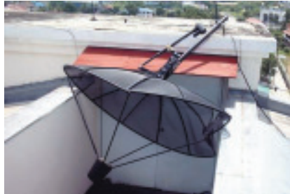
การติดตั้งจานที่ไม่ได้มาตรฐาน หรือไม่เรียบร้อยจะทำให้เกิดปัญหาจานล้มได้ง่าย
