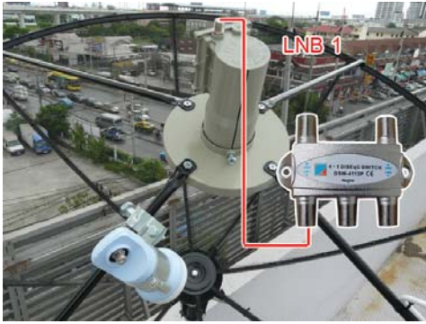
24. LNB C-Band ต่อเข้ากับ ช่อง LNB 1 ของ DiSEqC 4x1
