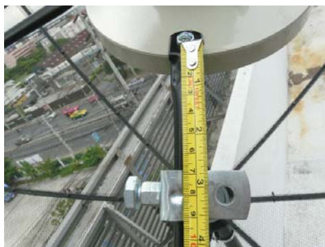
5. ใช้ตลับเมตรวัดระยะจากหัวสกรู ไปยังตำแหน่งมาร์คให้ได้ระยะ 8 ซม. สำหรับจานดาวเทียมรุ่น D1.5SW ส่วนรุ่น D1.3R ให้ยาว 6 ซม.
