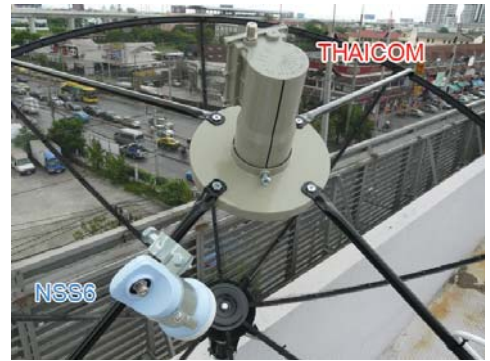
22. LNB ตัวใหญ่ รับผิดชอบ Thaicom ส่วน LNB ตัวเล็กรับผิดชอบ NSS-6
