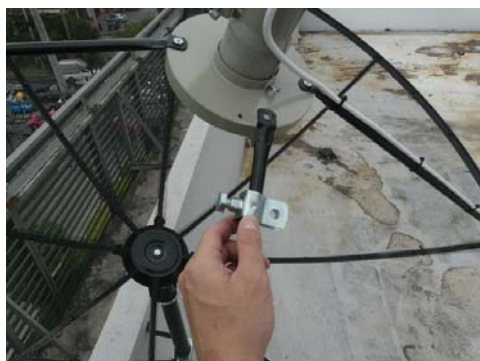
3. นำชุดยึด LNB KU มาใส่กับก้านพืด
