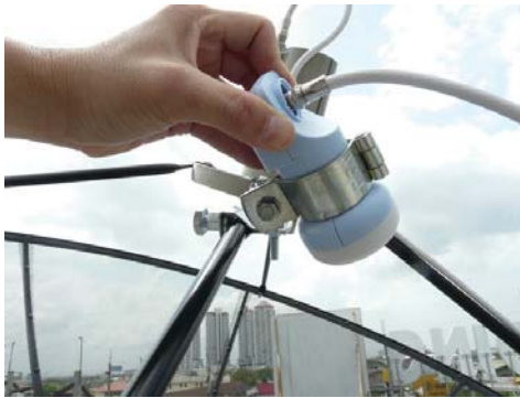
19. ปรับตัว LNB เียงซ้าย / ขวา จนได้ค่าคุณภาพสัญญาณสูงสุด
