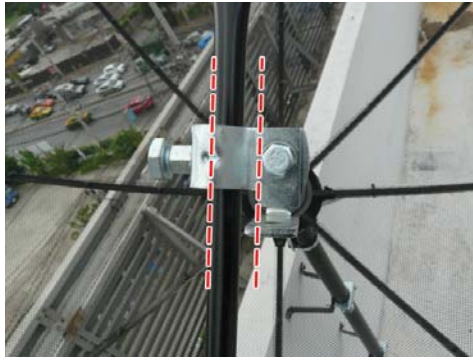
7. ปรับให้เหล็กฉากตัว L ขนานกับก้านพีดี
