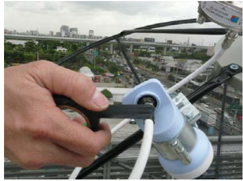
27. ใช้เทปพันละลายพันที่จุดต่อ F-TYPE ของ LNB KU เพื่อป้องกันน้ำเข้า
