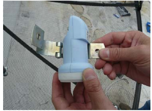
9. นำตัว LNB KU มาใส่เข้ากับขาจับ LNB
