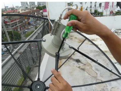
2. ถอดฝาครอบ LNB ออก ใช้ไขควงถอดสกรูตำแหน่งที่ยึดก้านพืดทางซ้ายล่างออก
