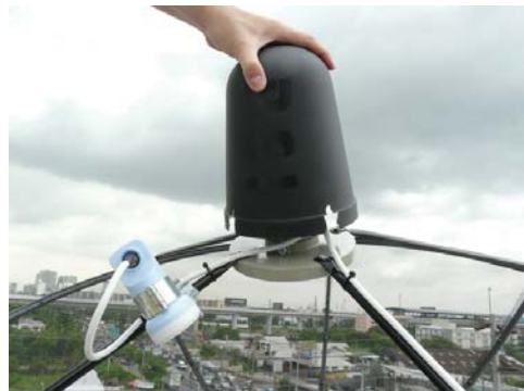
29. นำหมวกครอบ LNB มาได้กับสกาล่าร์ริง โดยให้ DiSEqC 4x1 อยู่ภายใน หมวก
