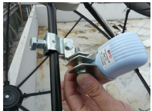
11. นำขาจับพร้อม LNB KU มาประกอบกับเหล็กฉากตัว L
