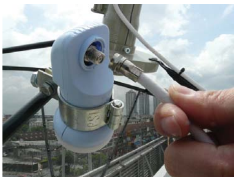
14. ต่อสายนำสัญญาณ เข้ากับ LNB KU
