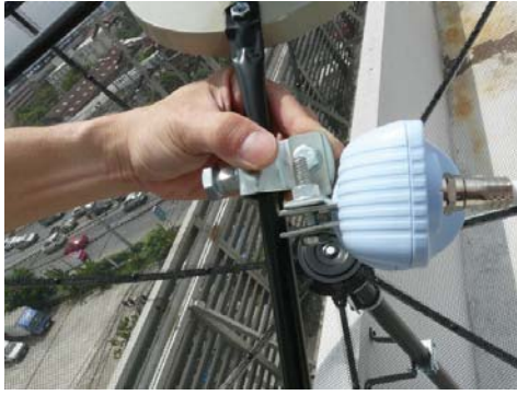
18. ปรับชุดยึด LNB KU ขึ้น หรือ ลง เพื่อหาคุณภาพของสัญญาณที่ดีที่สุด
