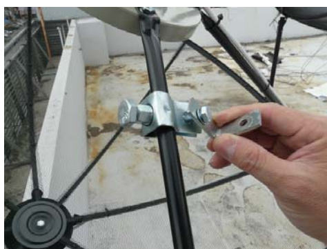
6. นำเหล็กฉากตัว L มาประกอบกับชุดยึด LNB KU
