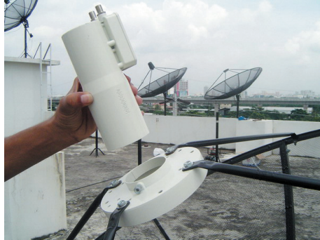
7. นำ LNB C2 มาใส่กับสกากลาร์ริง
