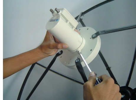
10. ทำการขันสกรูยึด LNB ให้แน่น
