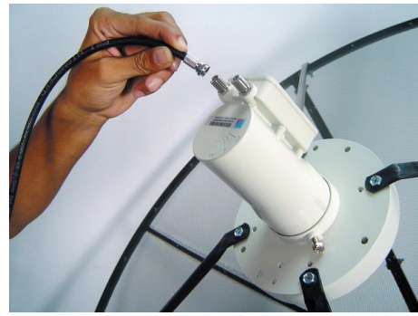
11. นำสายนำสัญญาณเส้นที่ 1 ต่อเข้ากับ LNB
