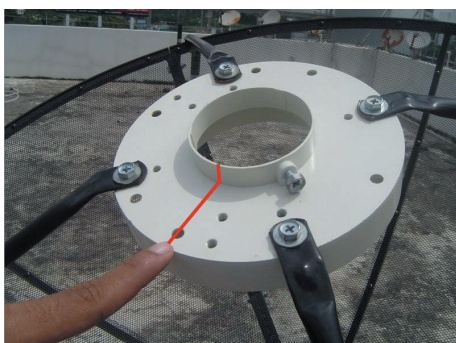
7. ตำแหน่งด้านล่างของสกลาลำรั้ง เมื่อเรายืนอยู่หน้าจาน และทำการขีดเส้นเพื่อใช้ในการปรับ LNB
