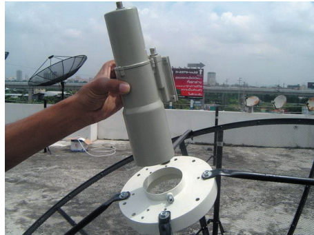
8. นำ LNB C/KU มาใส่กับสกลาลำรั้ง
