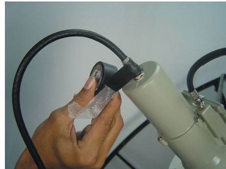
16. ใช้เทปพันละลายที่จุดต่อสายของ LNB เพื่อป้องกันน้ำเข้า
