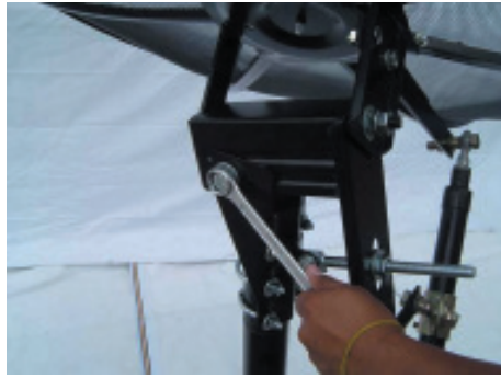
18. ให้ใช้ประแจขันน็อต ล็อคคกอลงไดเร็คชั่นให้แน่น จะได้ไม่ขยับเมื่อตอนทำการค้นหาตำแหน่งดาวเทียม
