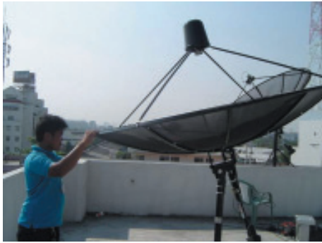
14. การตั้งหน้าจานให้หมุนไปทางซ้าย หรือขวา แล้วดูสัญญาณ ให้ทำขั้นตอนเหมือนกับการปรับมุมกมเงย
