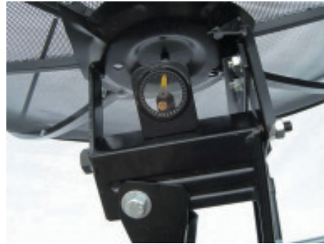
16. เข็มสีเหลืองของตัววัดมุมจะต้องชี้ไปตรงกับตัวเลขมุมก้มเงยที่ต้องการเช่น
