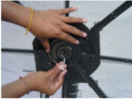
20. นำสกรูมาใส่เข้าที่แผ่นเหล็กยึดคอจานกับหน้าจาน
