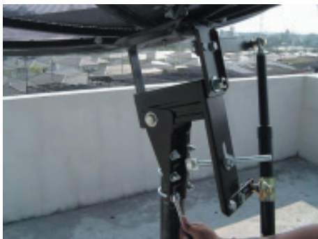
11. เมื่อปรับทิศได้แล้ว ให้ขันนอตรัดเสาให้พอดี
