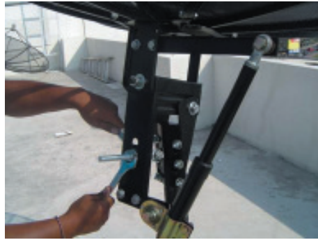
17. การตรวจสอบน็อตทุกตัวก่อนส่งมอบงาน ถือเป็นภาระกิจหลังของช่างติดตั้งทุกคนที่ต้องทำให้เป็นนิสัยเพื่อลดการกลับไปเซอร์วิส เสียเวลา และความรู้สึกลูกค้า ข้อมูลการใช้และโปรแกรมเครื่องรุ่น Dmove มีเพิ่มเติมในบทการใช้เครื่องด้านท้ายเล่ม
