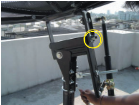
15. เมื่อทำการปรับละเอียดเสร็จแล้วให้ทำการขันน็อตยึดเสาให้แน่น (ยกเว้นแกนไดเรกชัน Direction ที่มีวงกลม สีเหลือง ห้ามขันเด็ดขาด)
