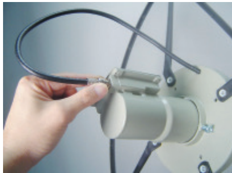
26. ใส่ F-Type กับสายและต่อเข้ากับจุด Connector LNB
