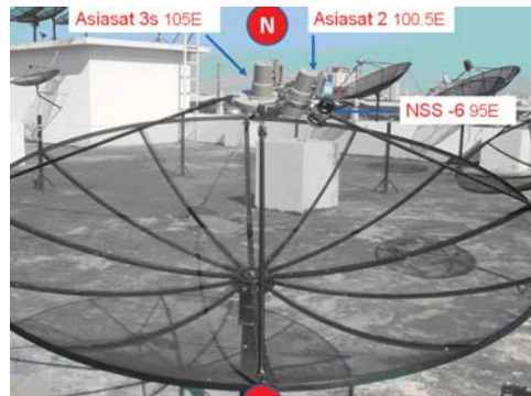
ติดตั้งจานรับดาวเทียม Asiasat 3 และ DUO Asiasat 2-NSS 6
